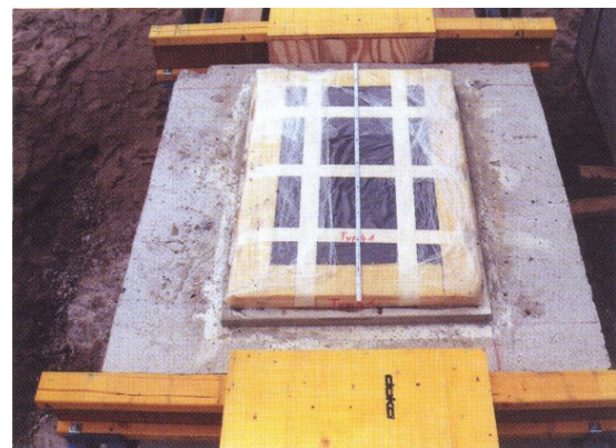
Justierung der Gleitlager auf Pfahlkopf
