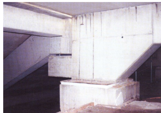
Einbausituation im fertigen Zustand
